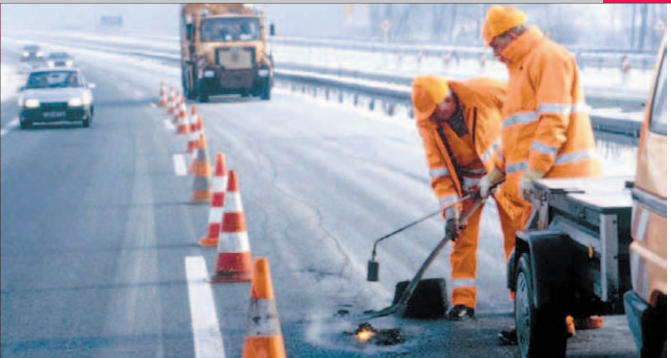
KARL-HEINZ MÜTZEL und BURKHARD LELL, Straßenwärter aus Oberthulba, Nordbayern
